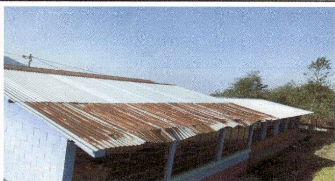
Foto 1: Sustitución de lámina, por lámina troquelada aluzinc calibre 26 + Sustitución de capote de lámina para lámina troquelada + Sustitución de elementos de fijación
