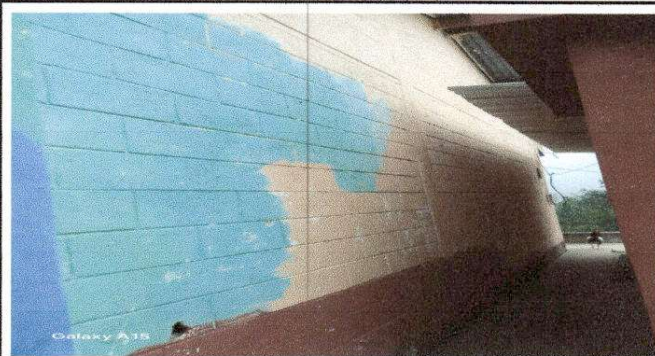
Foto 4: Pintura en muros exteriores e interiores
