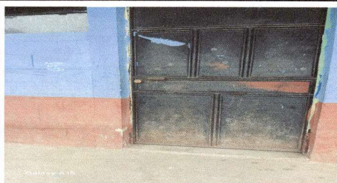
Foto 3: Sustitución de puerta
