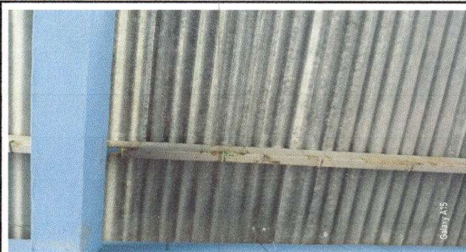
Foto 2: Mantenimiento de estructura de soporte de metal
